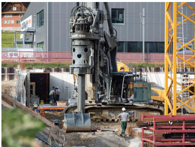
Bei der Pfahlherstellung.
