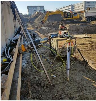
Die Baugrube ist mit 600 Selbstbohrankern und 41 Litzenankern gesichert; hier wurden die Qualitäts-
